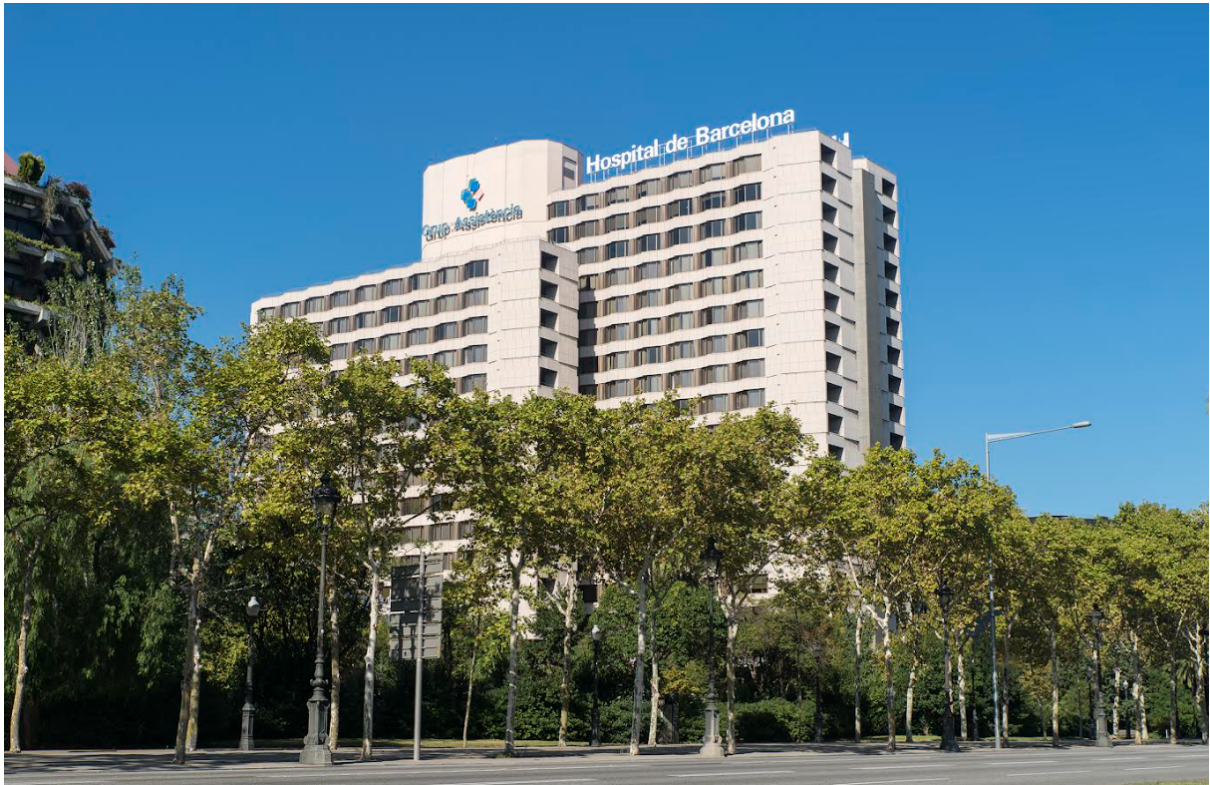
La façana de l'Hospital de Barcelona.
